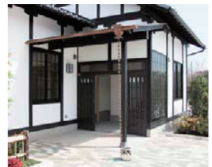
バリアフリーエントランス
